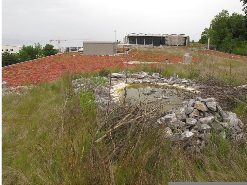
Chemin des roches, Lausanne
